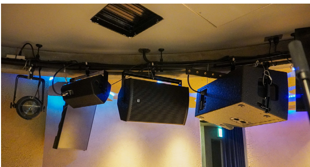
ステージ内からの様子。最左のスポット照明から続いて、NuQ62 (アウトサイドスピーカー)、NuQ102 (サイドフィル)、TBV123 (メインスピーカー)
