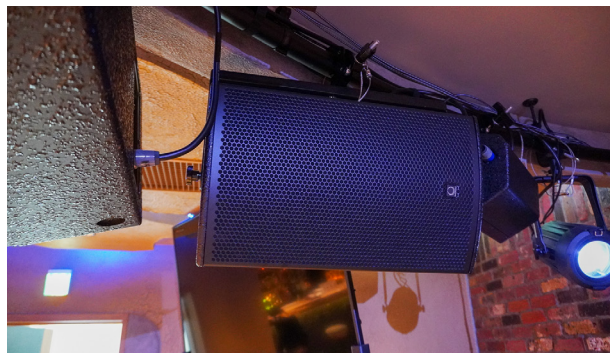
ステージ内から見上げた様子。サイドフィル NuQ102 を演奏者に向けて設置。スピーカーとスポット照明はステージを囲む半円形のバーに設置。
