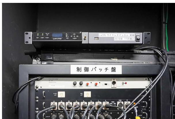
既存のインターフェイスを介して有線インカムと接続されています（自由劇場）
