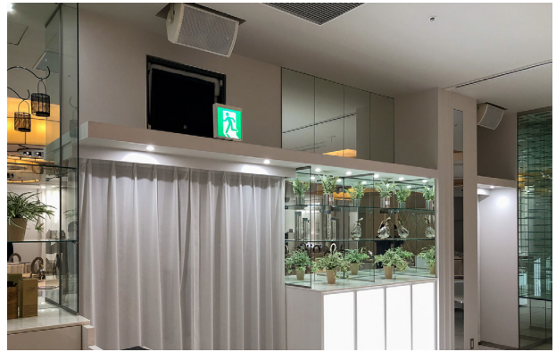
壁に埋め込まれている Turbosound NuQ115B と フライングヨークで吊るされている NuQ82-WH
