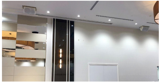
天井からフライングヨークで設置されている Turbosound NuQ82-WH
