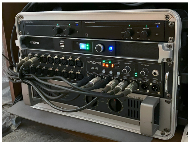
カウンター下にまとめられたアンプとミキサー類。 上から Lab.Gruppen CA2402、MIDAS M32C、MIDAS DL16
