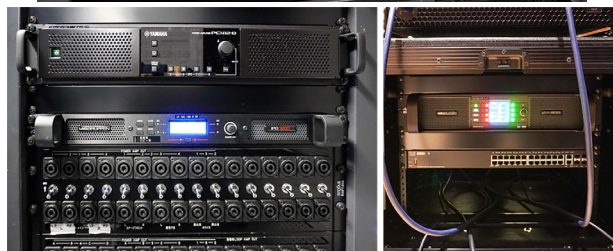
小ホール アンプラック、常設メインスピーカー Lab.gruppen PLM12K44 x1, 移動用ラインアレイスピーカー Lab.gruppen PLM12K44 x2, ステージフロント Lab.gruppen D40:4L x1, ホワイエスピーカー Lab.gruppen IPD1200 x2
