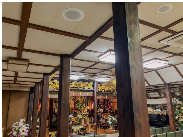
天井に取り付けられたシーリングスピーカー TANNOY CVS 401
