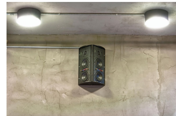
Cornered Audioのスピーカーは2本をカップリングして壁に設置することで180°のカバーエリアを提供します。1箇所配置するだけで廊下全体をカバーすることも可能です。3本カップリングした場合のカバーエリアは270°となりますので、L形状の部屋も1箇所に配置でき、配線や設置工事をミニマイズすることが可能です。
